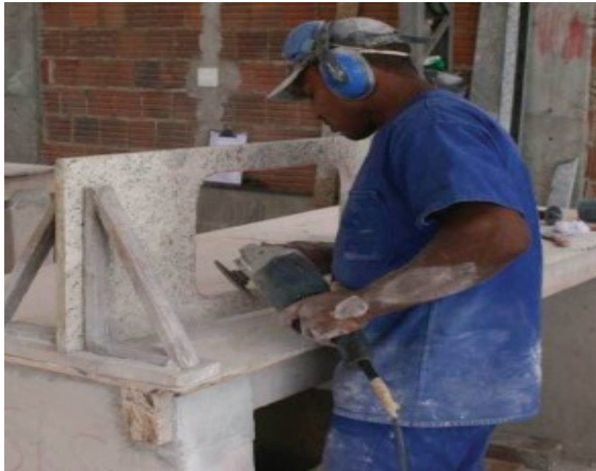
Figura 5: Geração de poeira no processo de lixamento
