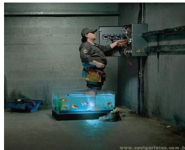
Figura 17 : Risco de acidente – Condições inadequadas de trabalho
