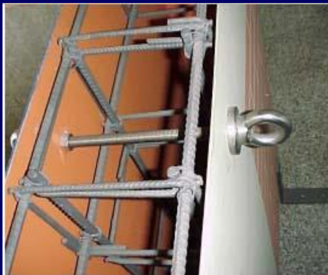
instalação dentro de viga de concreto
