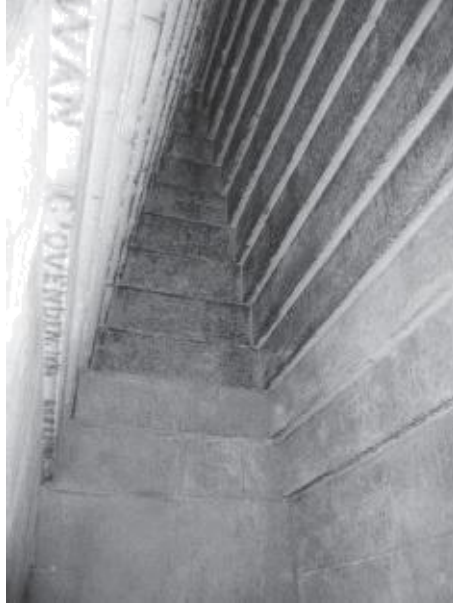
Figura 2.8. Teto corbeled em uma câmara da pirâmide vermelha. Cortesia de Jon Bodsworth.
