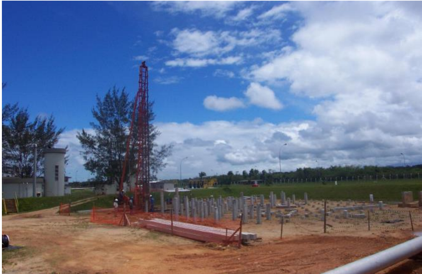
CONSTRUÇÃO DA BASE
