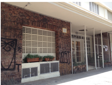
Figura 11. Acesso ao Edifício Maria Paula (acervo da autora, 2015)
