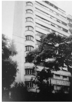
Figura 5. Fachada do Edifício Maria Paula (Caixa Econômica Federal, 2015)
