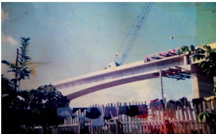
Figura 8.0 – Foto da época da construção da ponte, tirada entre 1997/1998.
