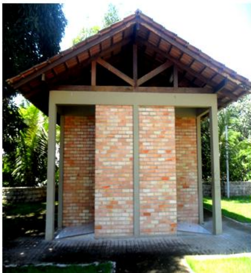
Fonte: Ornilda Santiago da Silva, 2013. Figura 10 - Vista da fachada do banheiro masculino.
