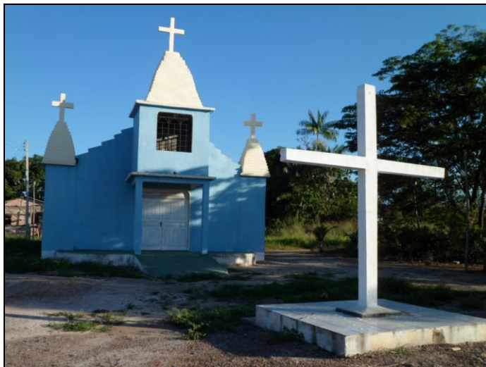
Figura 3.0 – Igreja São Pedro, às margens do Rio Branco, Vila de Vista Alegre, Caracaraí, Roraima.
