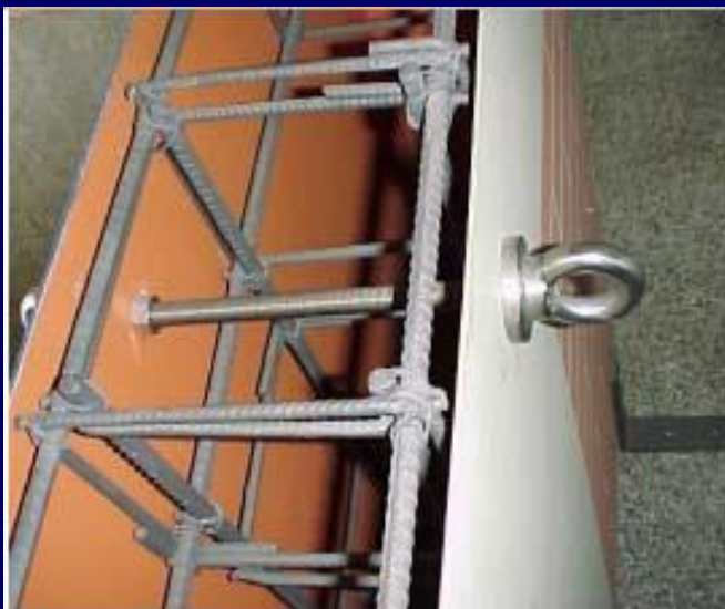
instalação dentro de viga de concreto
