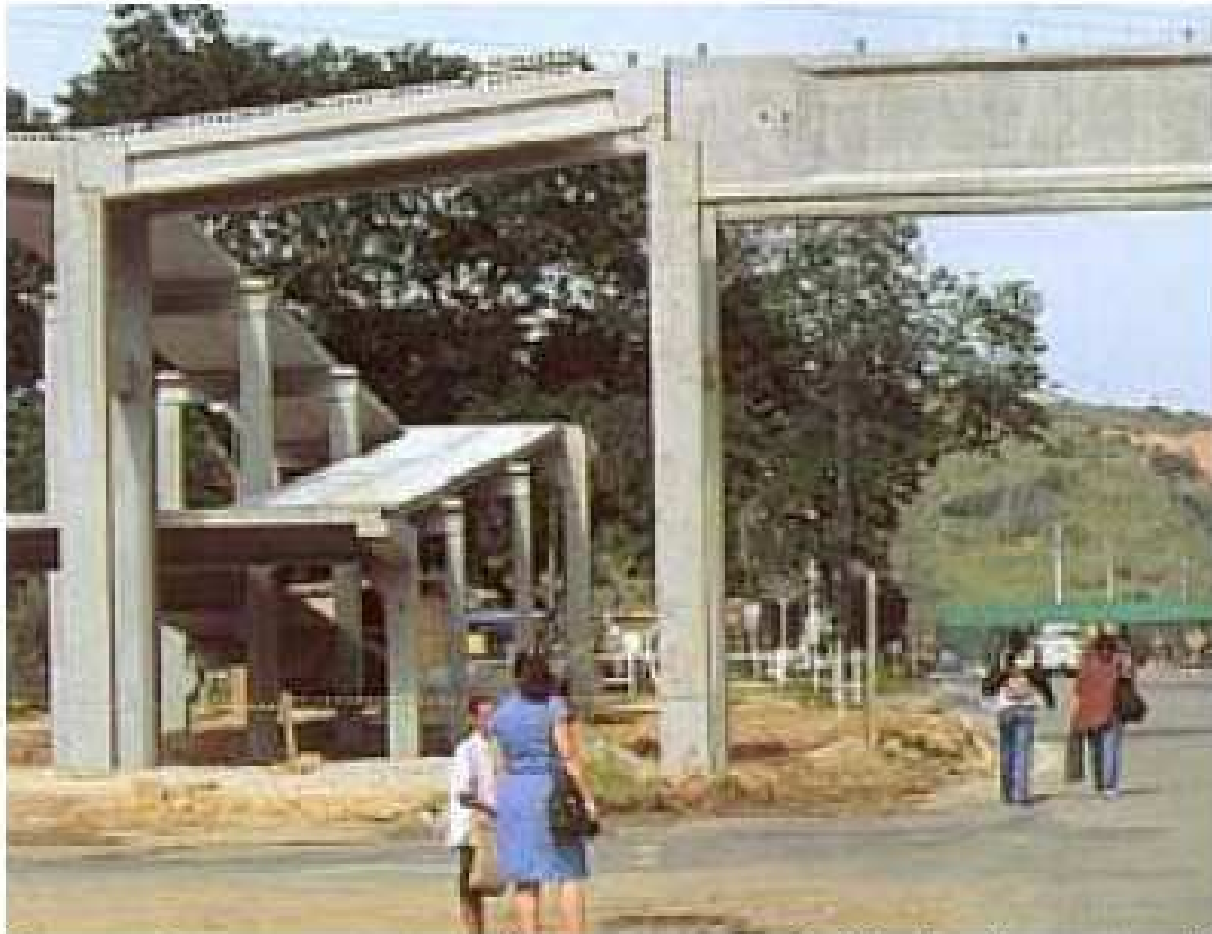
Passarela em estrutura de concreto pré-fabricado protendido
